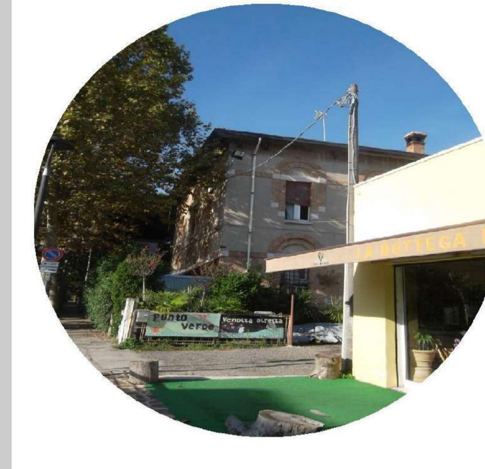
Stato di fatto con edificio di vendita fiori, che occlude la vista dell'edificio officina
